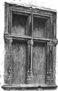
Fenster an der Hofseite des Hauses vom Conde de Ayamans.
