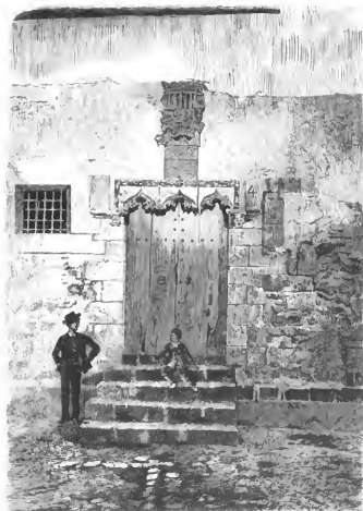
Puerta de la Antigua casa Consistorial.
