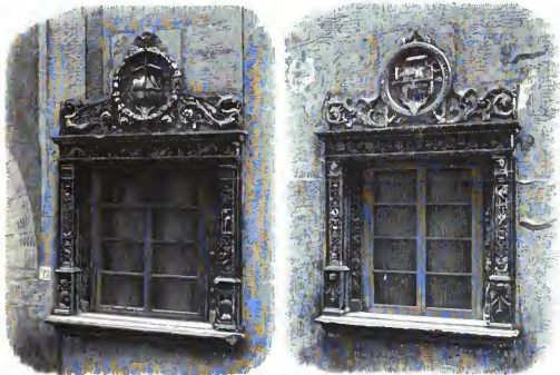
Fenster im Entresuelo an der Casa Oleza.
