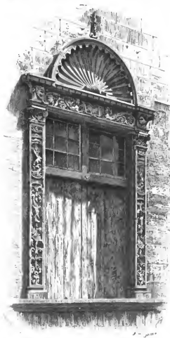
Fenster im ersten Stock der Casa Oleza.
